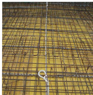
montáž topných kabelů TO-2H na kari síti
