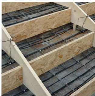
montáž topných kabelů TO-2H do venkovního schodiště
