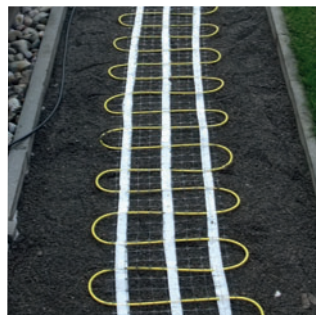
pokládka vykurovacej rohože HMO
