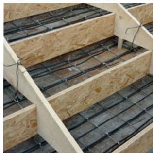
montáž vykurovacích káblov TO-2H do vonkajšieho schodiska
