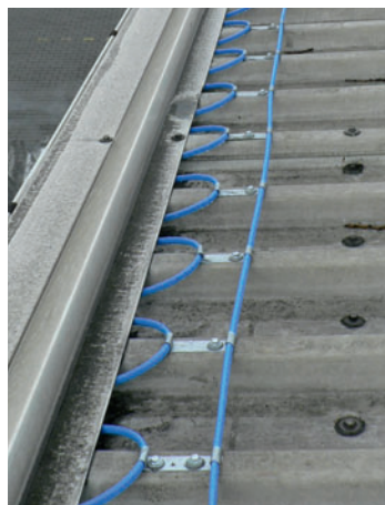
instalace topného kabelu na atypickém okraji střechy
