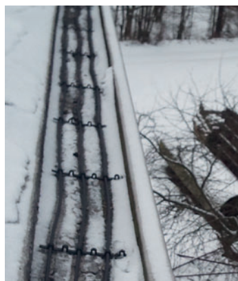
umístění vlhkostního čidla ETOR v hranatém okapovém žlabu
