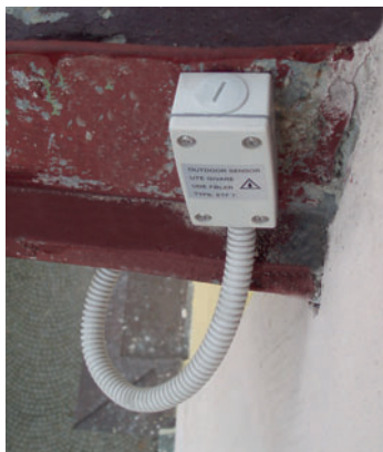
ukázky instalace teplotního čidla ETF
