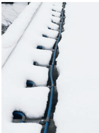
funkce topného kabelu instalovaného na atypickém okraji střechy
