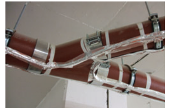
instalace topného kabelu na ochranu potrubí proti zamrznutí
