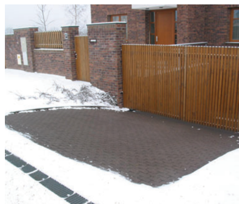
vyhřívání sjezd do garáže, Praha
