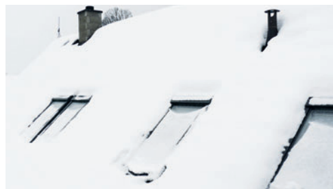
přimrzlá střešní okna, střední Čechy
