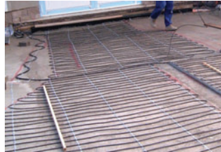
instalace topných kabelů na vyhřívání venkovní plochy
