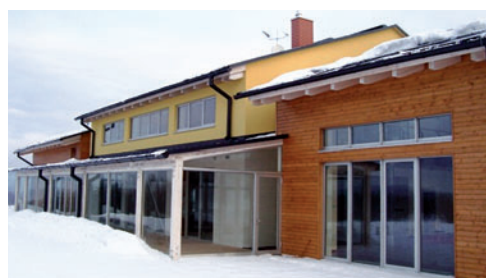
nebezpečné přístupové chodníky do objektů, Liberec
