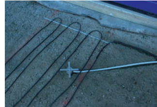
detail uložení vlhkostně-teplotního čidla ETOG a topných kabelů ve venkovní ploše před pokládkou dlažby
