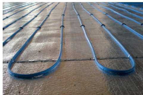
instalace dvoužilového topného kabelu před zalitím anhydritem
