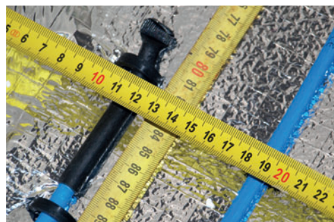
detail zaměření koncovky dvoužilového topného kabelu
