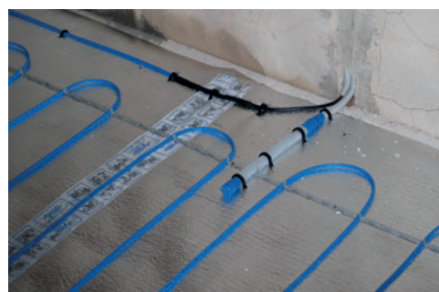
detail umístění instalační trubky pro podlahové čidlo
