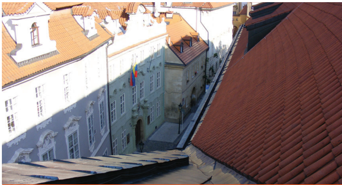
pohled přes malostranské střechy na typické řešení střešních krytin a okapů
