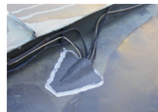
průchod přívodu napájení topných kabelů střešním pláštěm
