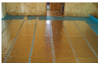
instalace topné rohože HML na OSB desky a kročejovou izolaci, přímo pod plovoucí podlahu
