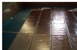
pokládka topných rohoží HML, detail vedení přívodů rohoží do instalační krabice a vynechání prostorů pro skříň
