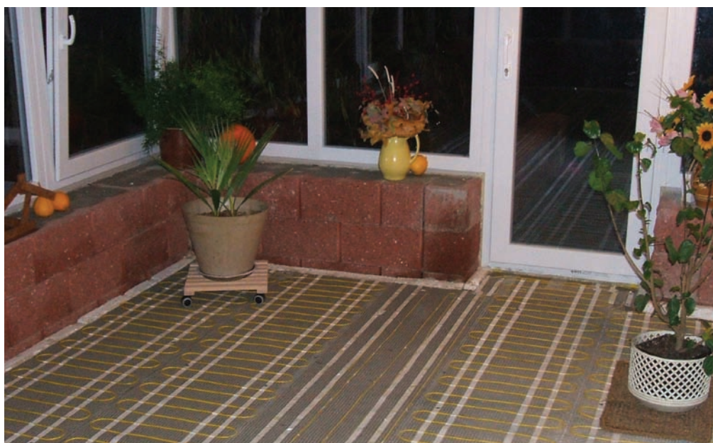
foto z instalace podlahového vytápění zimní zahrady
